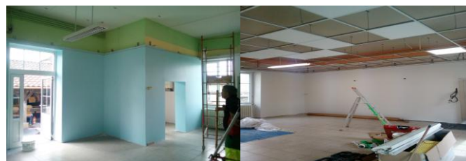
Pendant les travaux
